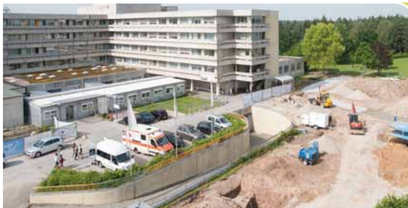
An der Nordseite des Klinikums begannen im Juni die Bauarbeiten für den neuen Wirtschaftshof.
